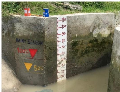
फोटो : JICA-TCP/PIAT कार्यक्रमको रेपलिकेशन साईटमा निर्माण गरिएको पानी बाडफाड गर्ने संरचनाहरु र अन्य कार्यक्रमहरु
