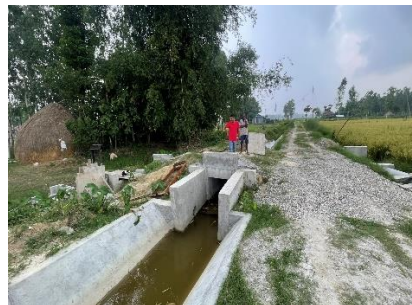
फोटो : JICA-TCP/PIAT कार्यक्रमको रेपलिकेशन साईटमा निर्माण गरिएको पानी बाडफाड गर्ने संरचनाहरु र अन्य कार्यक्रमहरु
