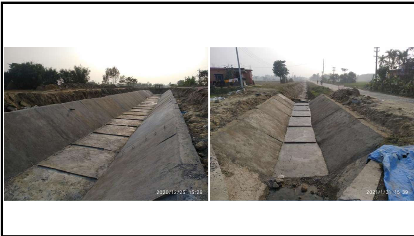
फोटो : रिच ४ र रिच ५ मा गरिएको मुल नहर लाईनिंग कार्य
