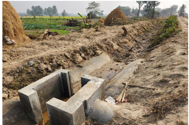
क.सि.व्य.का. र ज.उ.स. द्वारा मोडेल साइट शाखा नहर ४ का प्रशाखा नहर ११ मा नहर सफाई तथा खेतमा पानी व्यवस्थापन निर्माण क्रियाकलाप
